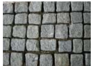
Afb. 1: voegen die zijn voorbereid
