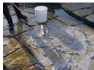
Afb. 6: bestrating met aangebrachte mortel, inwerken met een rubber trekker
