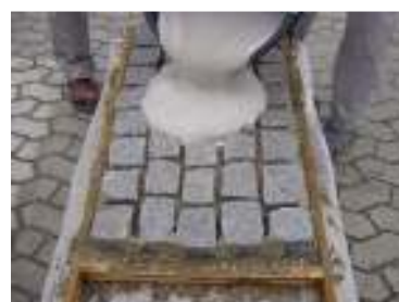
afb. 5 aanbrengen op bestrating
