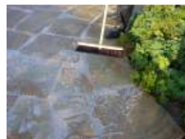
Afb. 7: afvegen van overtollige mortel
