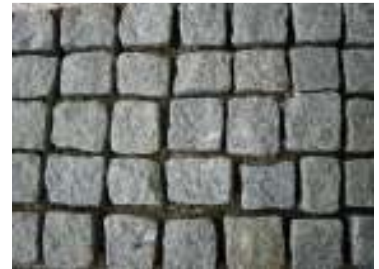
Afb. 1: voegen die zijn voorbereid
