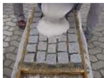
afb. 5 aanbrengen op bestrating
